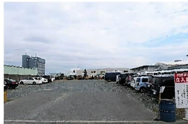
第2駐車場舗装前
