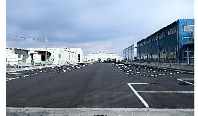
舗装後の第1駐車場
