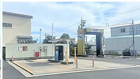
遠州梱包運輸(株)さん本社敷地内に 設置されているインタンクと洗車機
