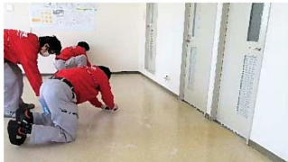
作業中の様子
