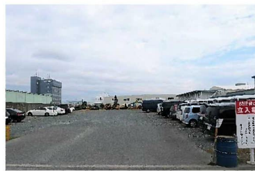
第2駐車場舗装前
